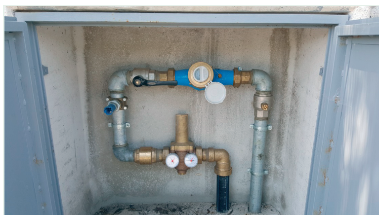
↑ Contatore con modulo trasmissione in frequenza 868 mhz in modalità WALK-BY
