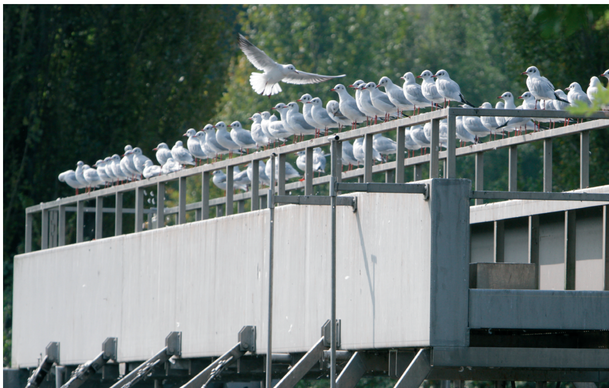
Un dettaglio del depuratore di Peschiera
