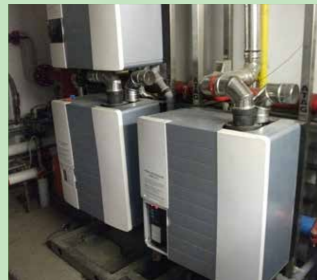
Qui sopra una delle Centrali Termiche installate negli edifici pubblici del Comune di Salò.
